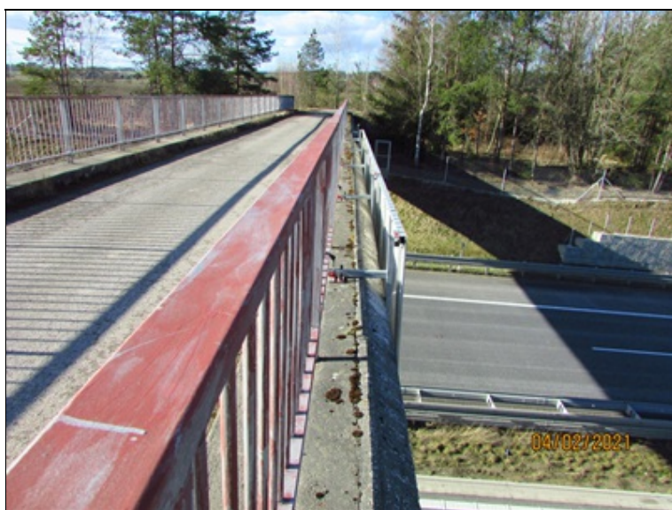
Ocelové závěsy reklamních poutačů jsou přikotveny k žlb. římse.
