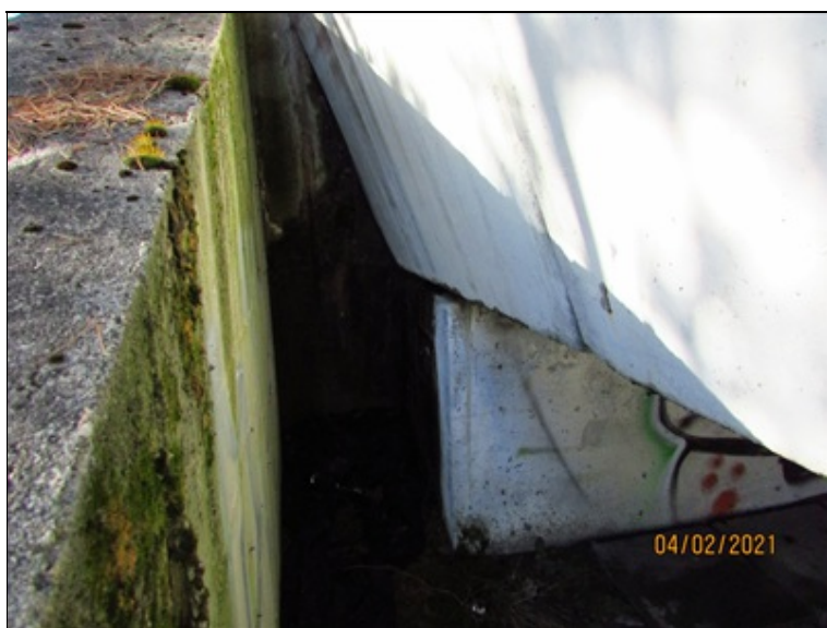
Mostním závěrem nad OP1 protéká voda na dolní desku opěry, výluhy pojiva.
