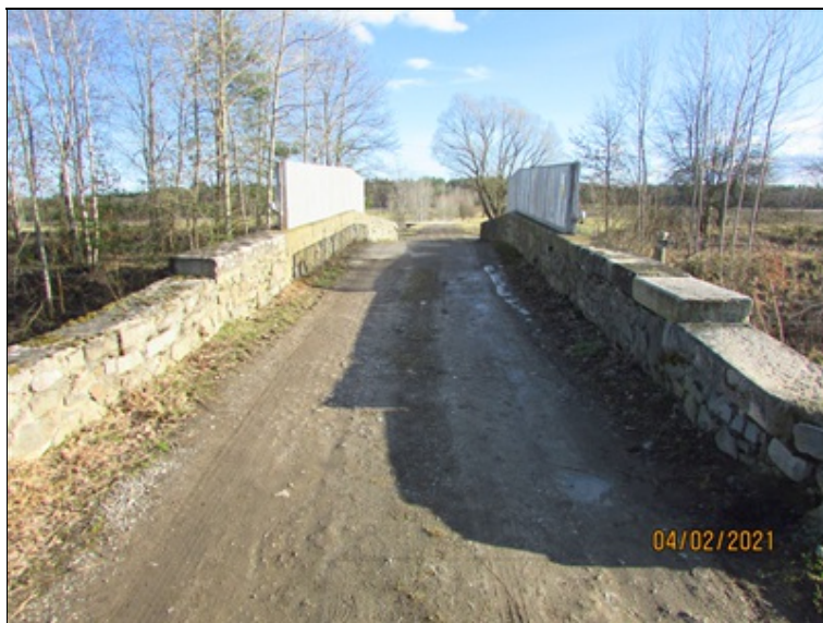
Příčné uspořádání na mostě, pohled ve směru staničení. Na křídlech OP1 chybí horní kamenné desky.
