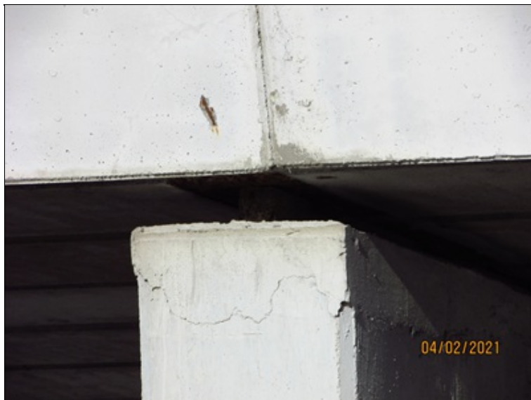
Ocelové kolejnicové ložisko na P3
