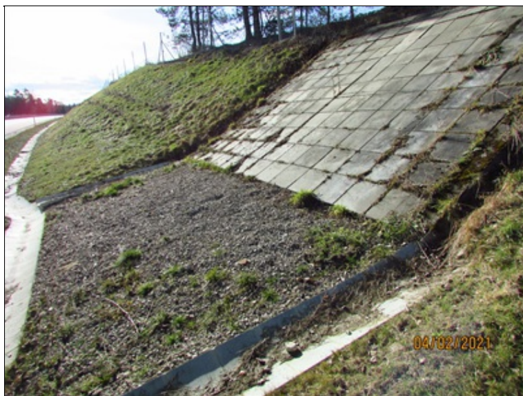
Opevnění svahu před OP1 : vegetace, dlažba z bet. desek je rozvolněná místy prosednutá.
