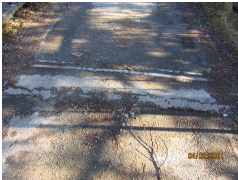
Sednutí vozovky před OP1. Mostní závěr je zanesený
