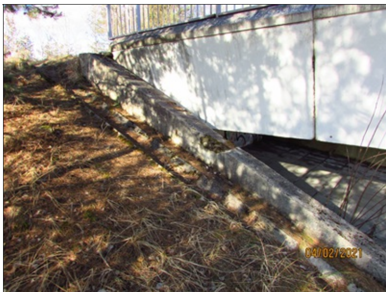
Pravé křídlo OP1 : lokálně trhliny, degradovaný beton.
