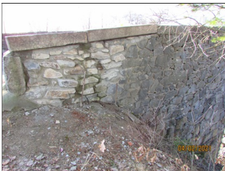
Levé křídlo OP2. Zřejmě dodatečně přezděné
