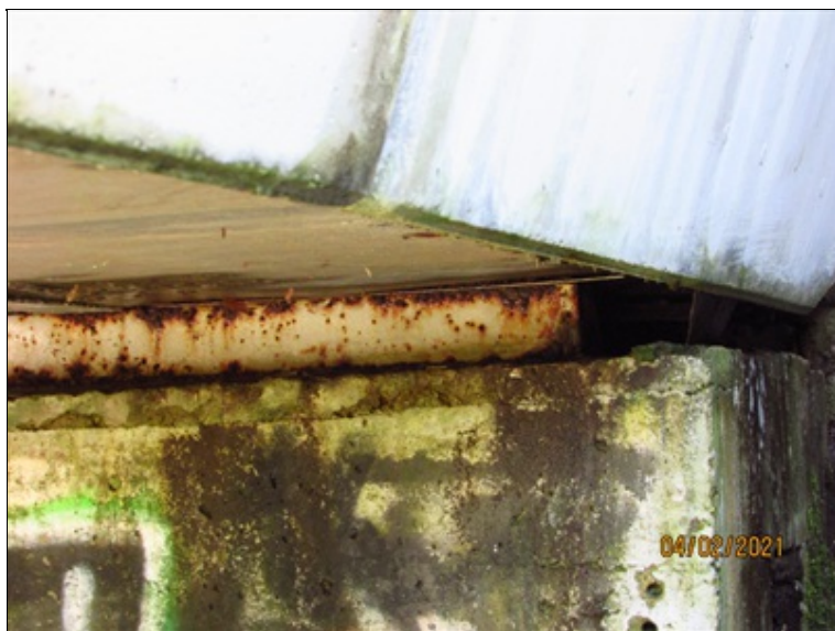
OP1 : ocelové kolejnicové ložisko koroduje, lokální degradace betonu.
