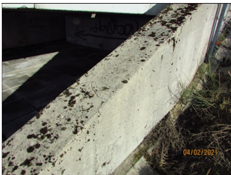
Pravé křídlo OP4 : trhlina šířky 0,30 mm.
