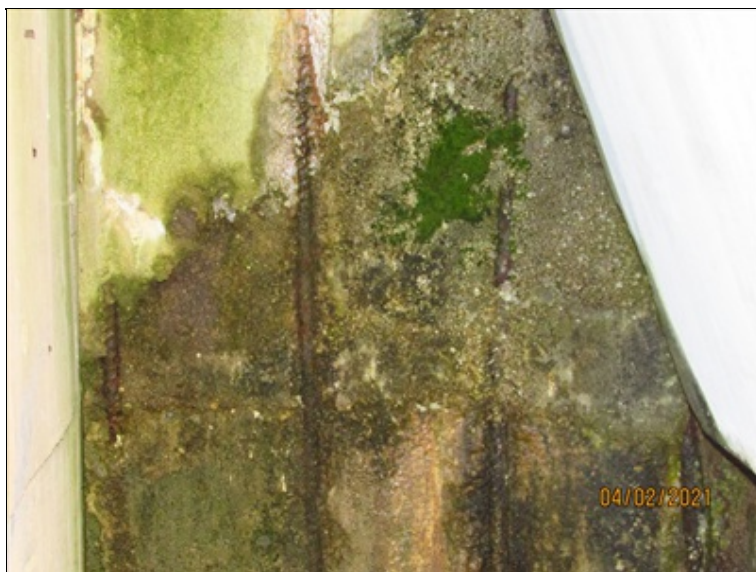
Závěrná zídka OP1, líc : prosakování vody, obnažená výztuž koroduje, odpadá krycí vrstva betonu
