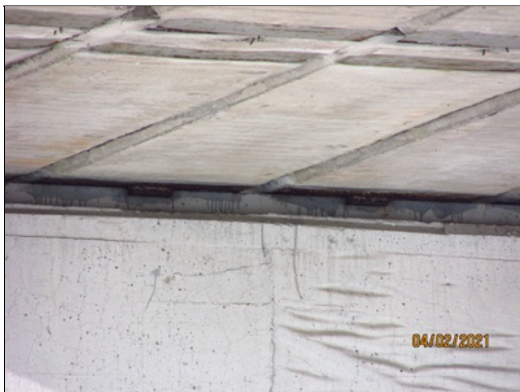
Ocelové kolejnicové ložisko na P3
